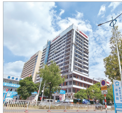
省级区域医疗中心一期项目(急重症诊疗大楼)即将投入使用
